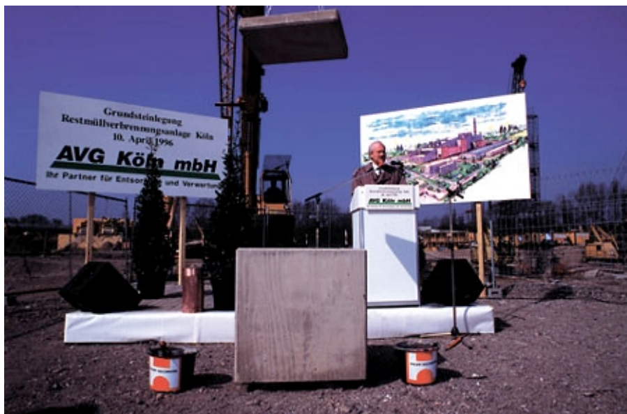
Endlich am Ziel: Oberstadtdirektor Lothar Ruschmeier bei der MVA-Grundsteinlegung
