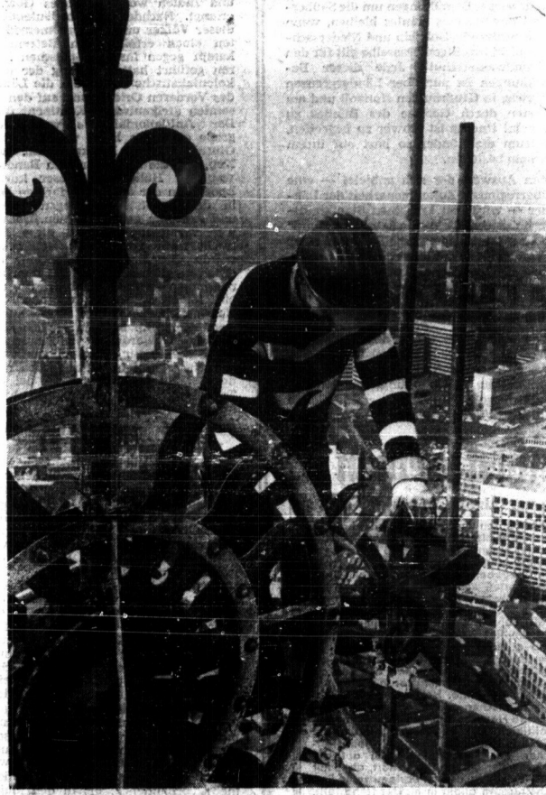
Dieses Foto zeigt einen Blick von Hamburgs höchster Baustelle auf die Innenstadt. In 147 Meter Höhe barg Oberamtsbauverwalter Kurt Heck in der Turmruine von St. Nikolai eine Kassetten mit wertvollen Dokumenten. Sie soll in der kommenden Woche geöffnet werden. Der Turm der im Kriege zerstörten Hauptkirche wird, wie berichtet, zum Mahnmahl für die Opfer des Dritten Reiches.
