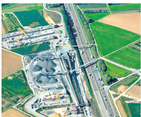
Der Tunnel wird von Kirchheim aus Richtung Wendlingen gegraben. Foto: Bahn/Kilgus
