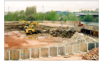
Aushub kontaminierter Bodenzonen
