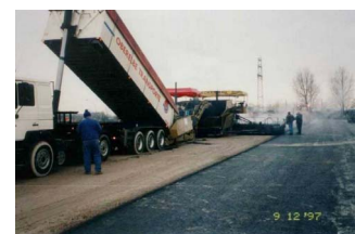
Herstellung der Asphalttragschicht
