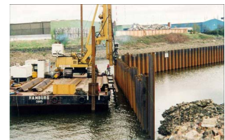
Rammen der Spundbohlen im Moorfleeter Kanal
