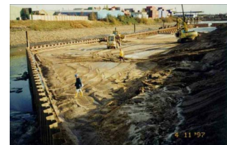
Hinterfüllung der Ufersicherung
