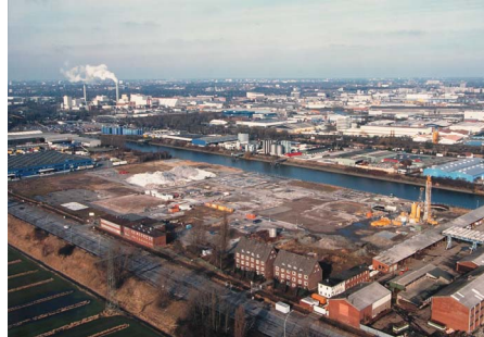
Rückgebautes Werksgelände Anfang 1997
